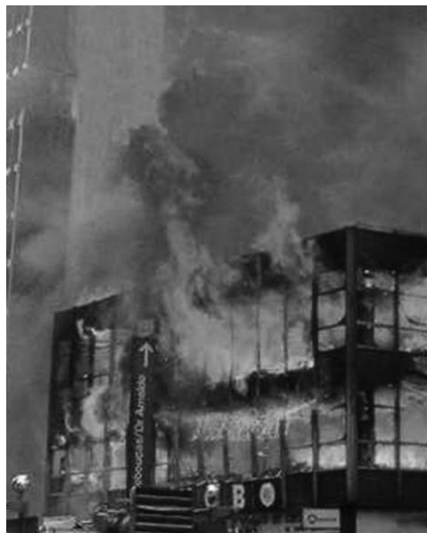
Foto do incêndio no Edifício Grande Avenida
