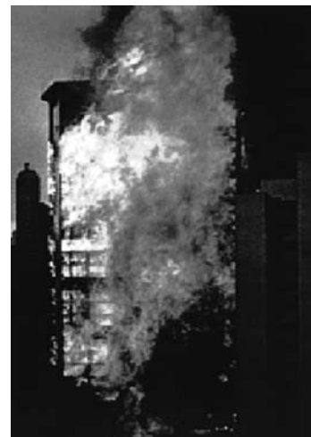
Foto do incêndio do Edifício Andraus
