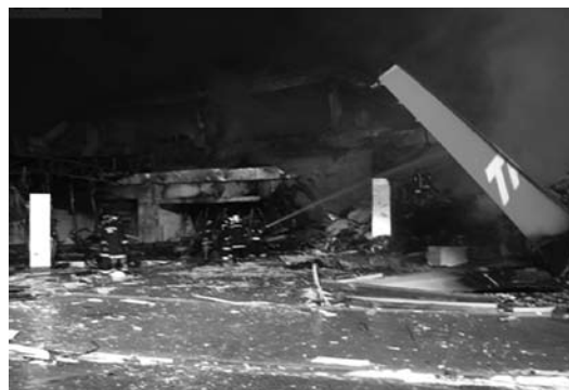
FIGURA 01 - Extinção de incêndio provocado por queda de aeronave Fonte: Corpo de Bombeiros de São Paulo. 2007
