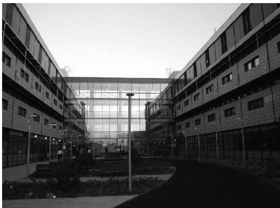
FIGURA 14: Área externa e passarelas de conexão com as edificações
